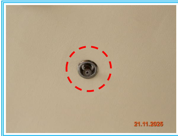
รูปที่ 3-57 หัวกระจายน้ำดับเพลิง
