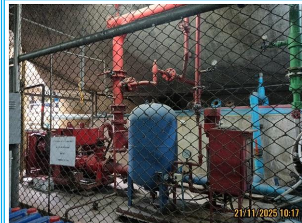
รูปที่ 3-48 ระบบปั้มน้ำดับเพลิง
